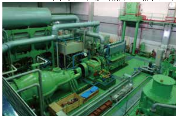
↓水野ポンプ場の改築された雨水ポンプ
