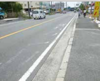
大阪生駒線2車線拡幅整備中
