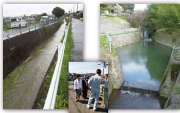
清滝川の浚渫工事後
