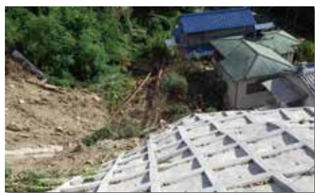
大阪生駒線 斜面崩落現場 (台風18号)
